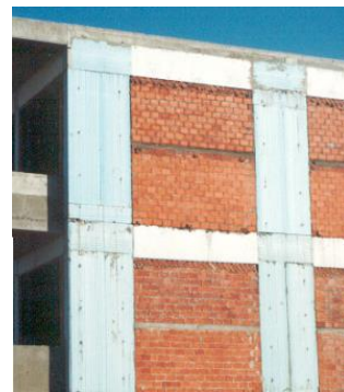
Εξωτερική θερμομόνωση σκελετού σε νέα κατασκευή.
