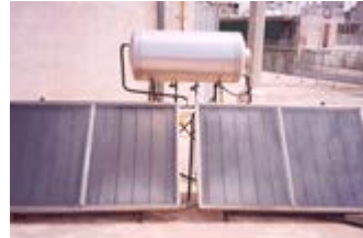
Αντιπροσωπευτική διάταξη ηλιακού συστήματος παραγωγής ζεστού νερού.
