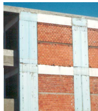
Εξωτερική θερμομόνωση σκελετού σε νέα κατασκευή.
